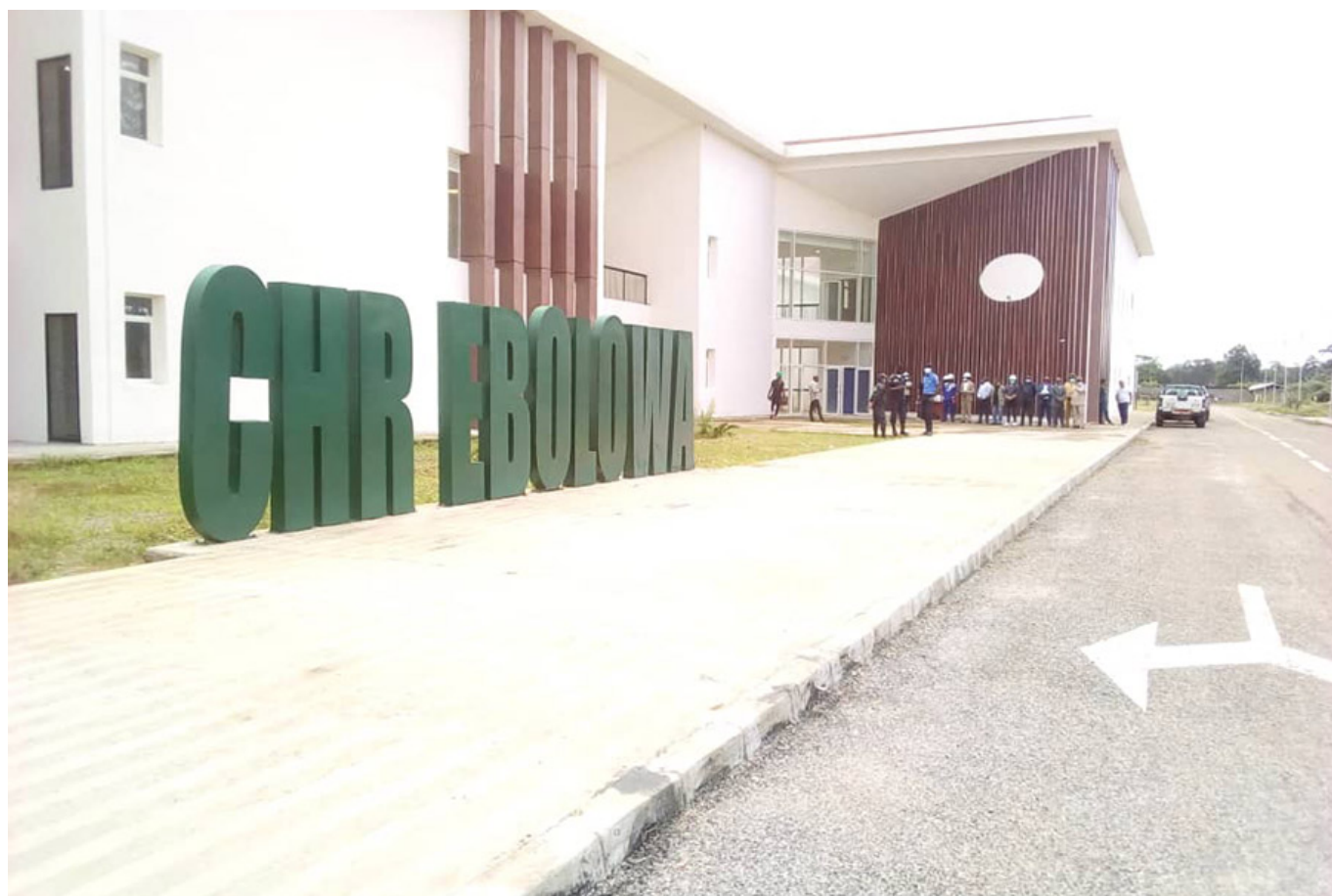
Une vue de la façade avant du Centre Hospitalier Régional d'Ebolowa
