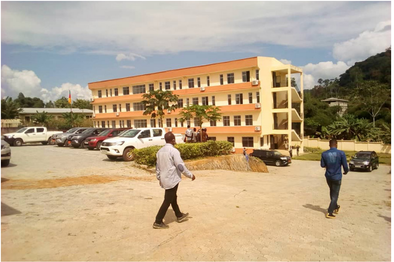
La Délégation Régional du Minmap/Sud nouvellement construite.
